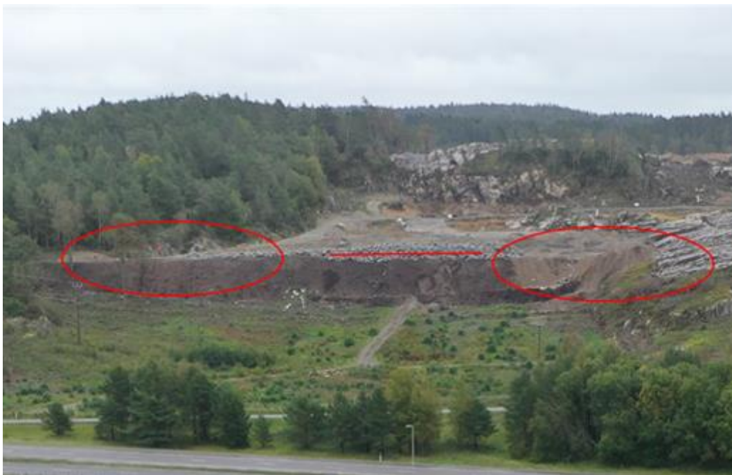
Figur 40. Uppfyllnad utförd som vall med genomförd avsläntning tre dygn före skredet. Uppfyllnaden med arbetsväg och sprängsten markerat med ett rött streck. Arbetsvägen knöt samman berg markerat med röd ring på ömse sidor av uppfyllnaden. Bilden är beskuren av SHK. Foto: Mikael Berglund.
