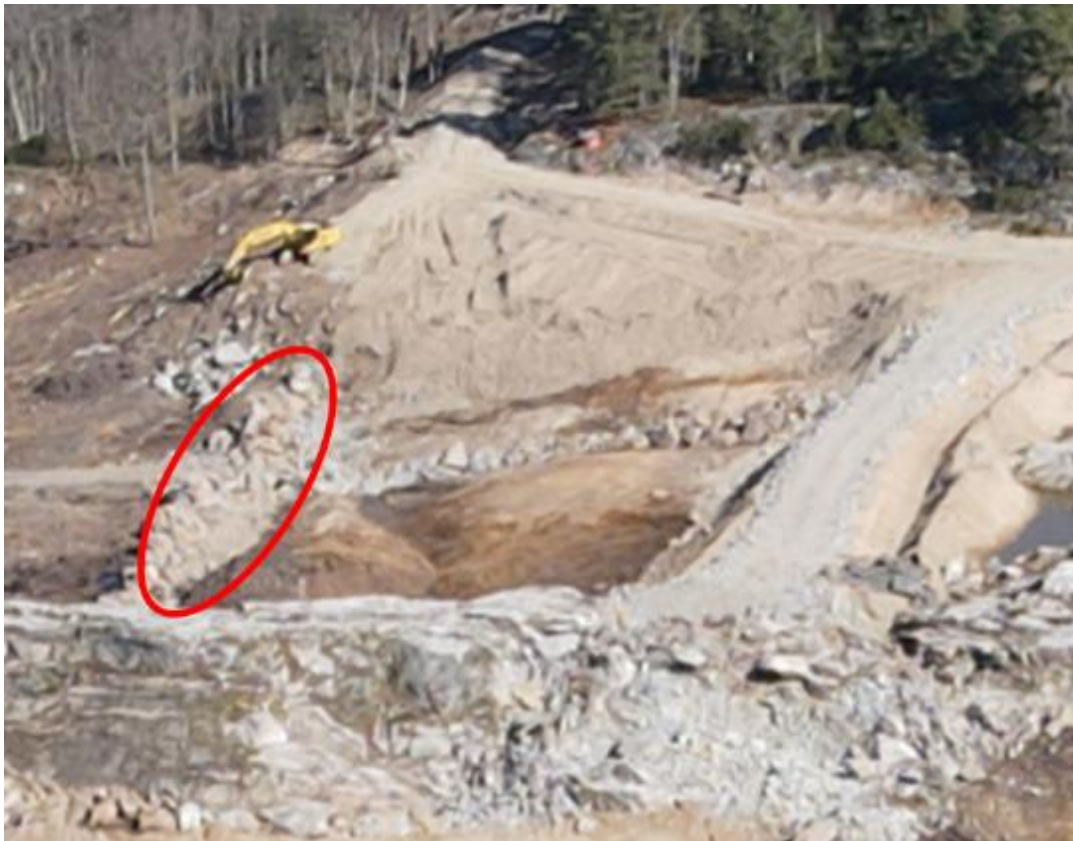
Figur 38. Fotografi som visar markarbeten på fastigheten Hammar 1:14. Det översta jordlagret var vid detta tillfälle bortschaktat. Bilden är beskuren och till vänster i bilden ses stenar som lades i botten av vällen, markerat av SHK med en röd ring. Foto: Privat.
