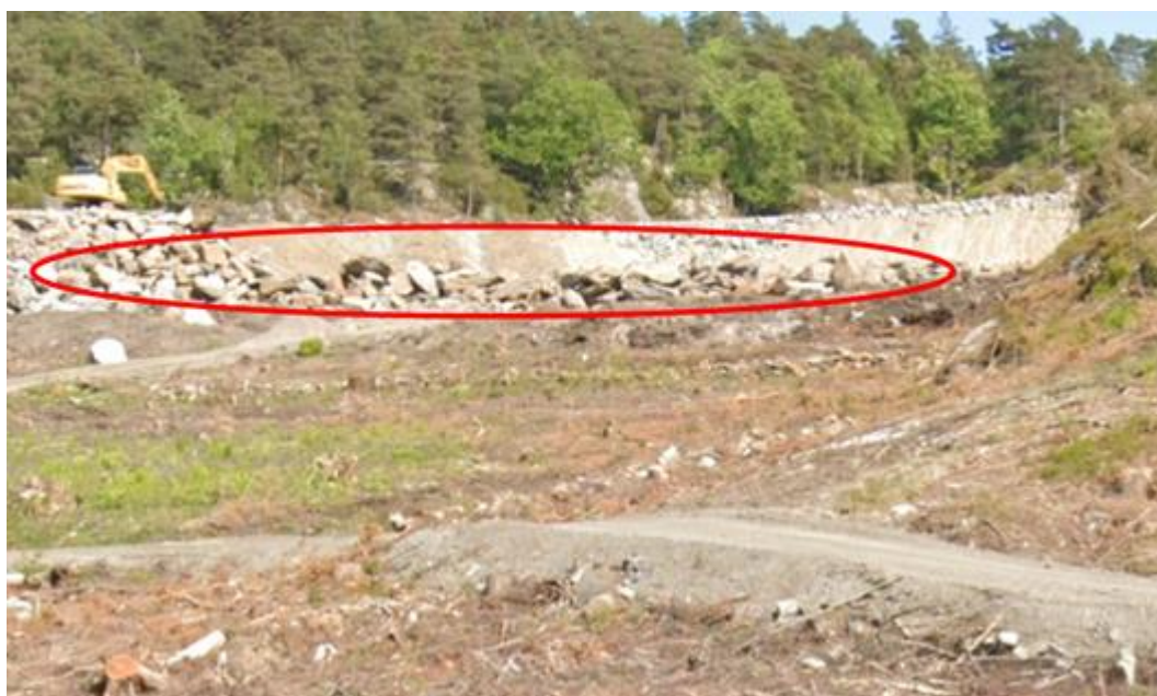
Figur 39. Inledande arbeten för att bygga vallen, markerat av SHK med röd ring, på fastigheten Hammar 1:14. Underbyggnad av större stenblock. Foto: Google Maps.
